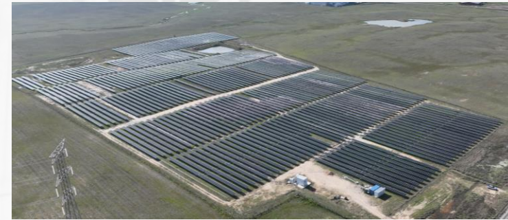
Parque solar Calzada de Oropesa Planta fotovoltaica de 7,6 MW Castilla y La Mancha, Toledo
