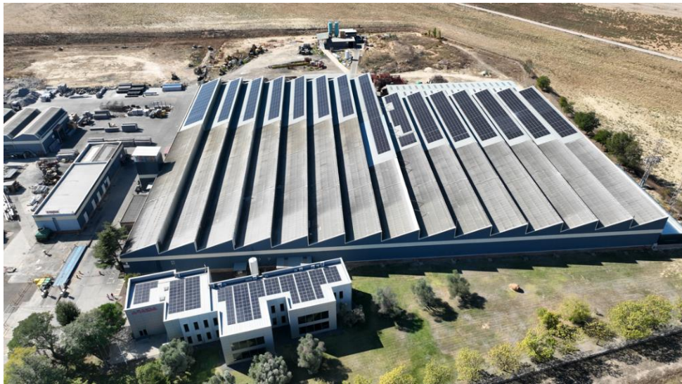
Planta fotovoltaica de Autoconsumo industrial de una potencia de 800 KWp en Castilla y León para Riegos Agrícolas Españoles SA. Fecha de finalización: Abril 2024
