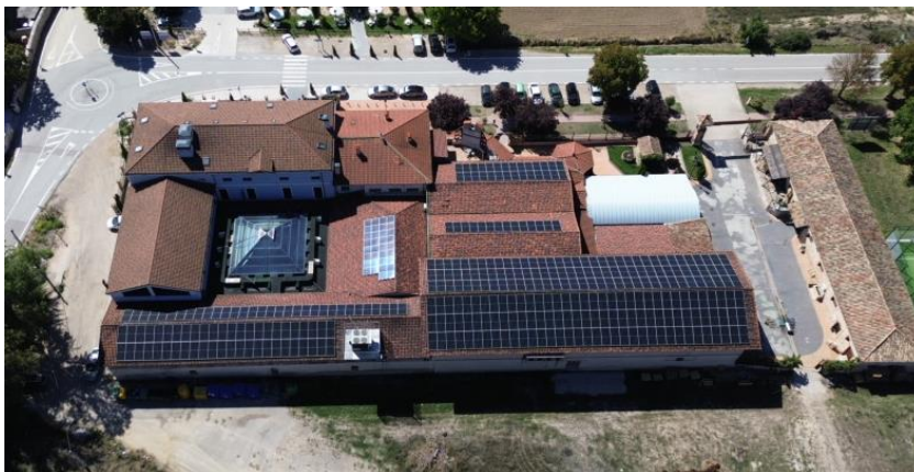
Instalación fotovoltaica de autoconsumo industrial sobre cubierta para Bodegas Lagar de Isilla. Potencia de 192 Kw . Castilla y León
