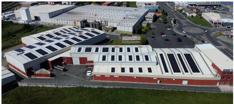
GRUPO INTAF SA Planta de autoconsumo fotovoltaico de 329.85 Kwp de potencia en a Coruña, Galicia. Finalización Febrero 2024
