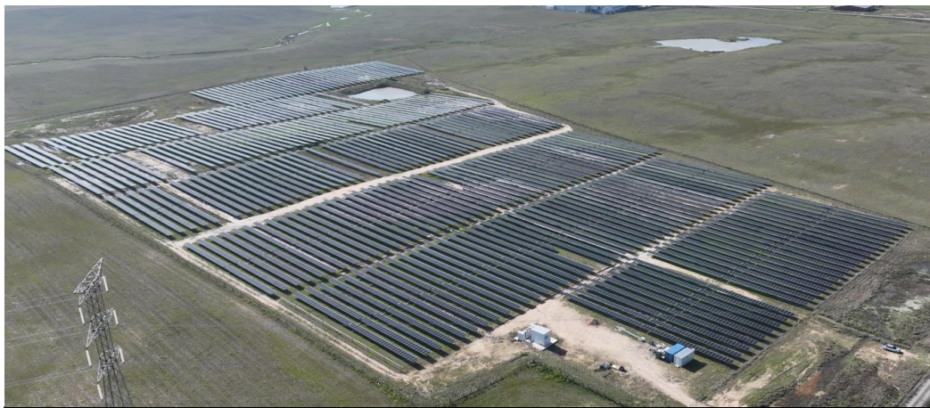
Parque solar propio del Grupo EiDF en Castilla y la Mancha, Toledo Calzada de Oropesa. Planta fotovoltaica de 7.6 MW de potencia.
