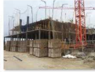
EN CONSTRUCCIÓN Quabit Torrejón V.P. 1. Madrid 51 viviendas
