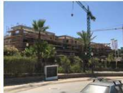
EN CONSTRUCCIÓN Quabit Casares Golf 1 y 2. Málaga 87 viviendas
