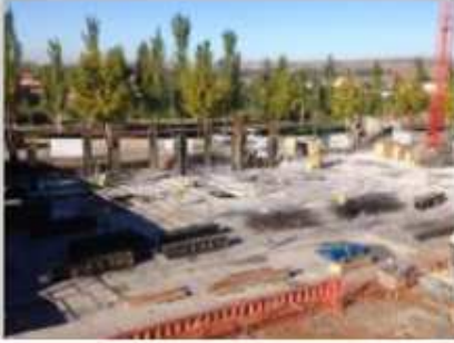
EN CONSTRUCCIÓN Quabit Aguas Vivas 2. Guadalajara 196 viviendas
