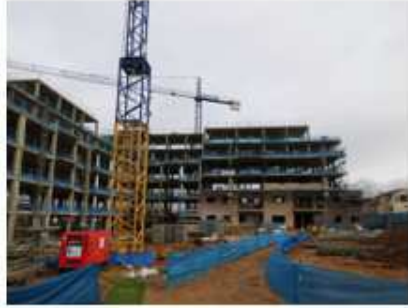
EN CONSTRUCCIÓN Quabit Style 1. Guadalajara 64 viviendas
