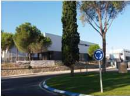
EN CONSTRUCCIÓN Quabit Las Lomas. Madrid 12 viviendas
