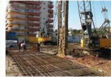
EN CONSTRUCCIÓN Quabit Los Pedregales 1. Málaga 63 viviendas
