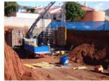
EN CONSTRUCCIÓN Quabit Altair. Málaga 32 viviendas
