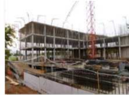
EN CONSTRUCCIÓN Quabit Parque Residencial. Guadalajara 76 viviendas
