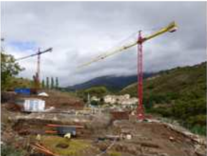
EN CONSTRUCCIÓN Quabit Riverside. Málaga 75 viviendas
