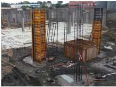
EN CONSTRUCCIÓN Quabit Torrejón V.P. 2. Madrid 45 viviendas
